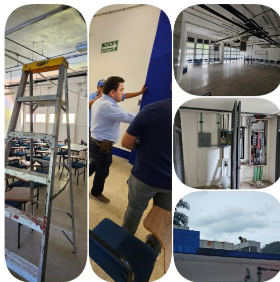
Imagen 1. Continuidad de mantenimientos e instalación de equipos de aire acondicionado de laboratorio de Horticultura con el fin de utilizar espacios como aulas.
