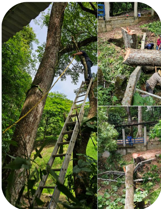
Imagen 4. Poda y derrame de árboles que representaban un riesgo para usuarios de pasillos y andadores.
