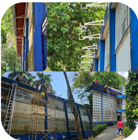
Imagen 6. Mejoramiento y mantenimiento del edificio académico.
