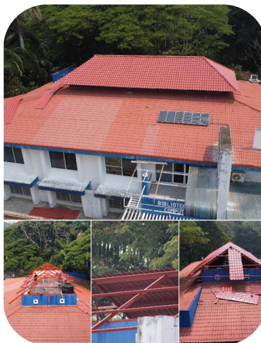
Imagen 5. Construcción de techado en azotea de la biblioteca.
