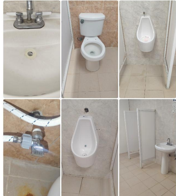
Imagen 17. Baños de hombres y mujeres en biblioteca; cancelación de toma de agua, adecuación del drenaje, instalación de 2 mingitorios secos y cambio de cespel en lavabo por fuga (baño hombres), además de reparación de toma de agua para el wc y destapado de un wc (baño mujeres).
