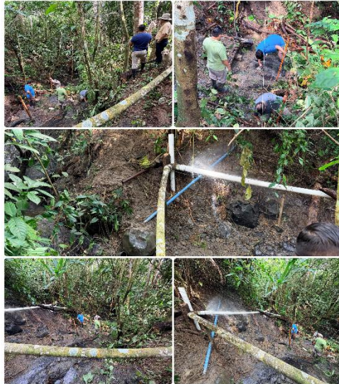
Imagen 24. Adecuación, reinstalación y mantenimiento a la tubería de agua general que abastece a la URUSSE.
