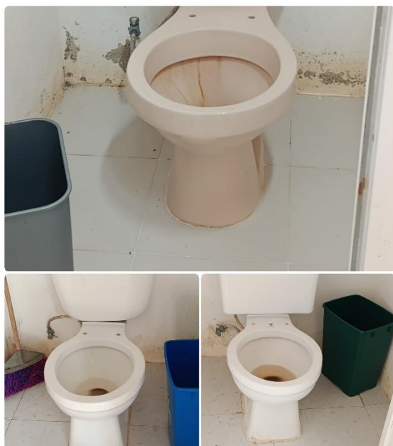
Imagen 22. Cambio de herrajes y mantenimiento general de los baños de los talleres deportivos.
