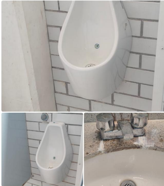
Imagen 16. Cancelación de toma de agua (baño hombres), adecuación del drenaje (baño hombres), instalación de 2 mingitorios secos (baño hombres), reparación de llave mezcladora (baño mujeres) del edificio de Ganadería Tropical.
