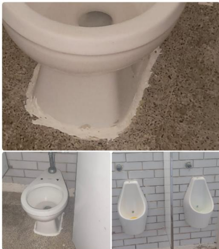
Imagen 18. Cancelación de toma de agua, instalación de 2 mingitorios secos y adecuación de drenaje y reinstalación de 2 WC en el edificio de Horticultura.
