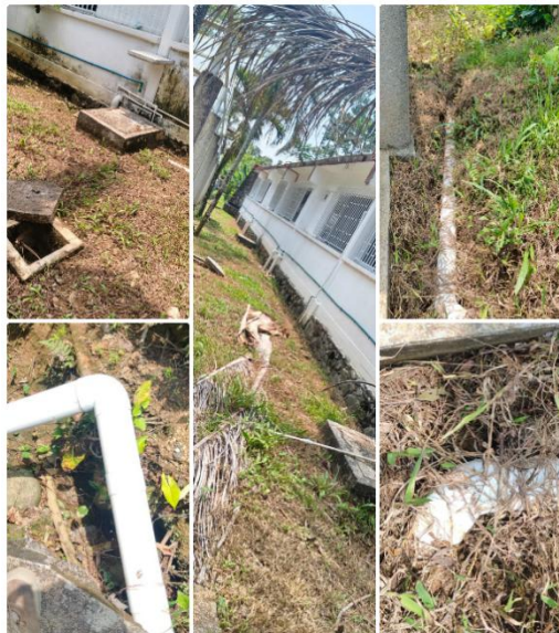
Imagen 26. En la Unidad de Servicios Habitacionales de la URUSSE se realizó limpieza de registros tapados, nueva derivación del drenaje principal ya que se encontraba completamente tapado, se limpió la poza séptica la cual contaba con bastantes residuos sólidos y se dejó completamente limpio.
