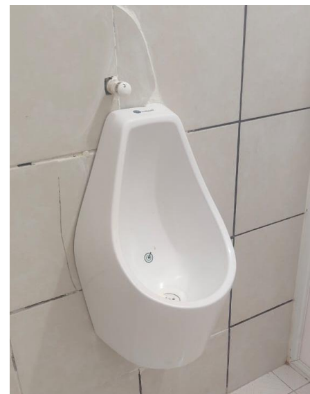
Imagen 20. Cancelación de toma de agua y adecuación del drenaje para instalación de mingitorio seco en el edificio administrativo.
