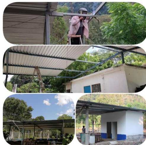
Imagen 9. Reparación de la galera del área de agricultura y techumbre de lombricomposta.
