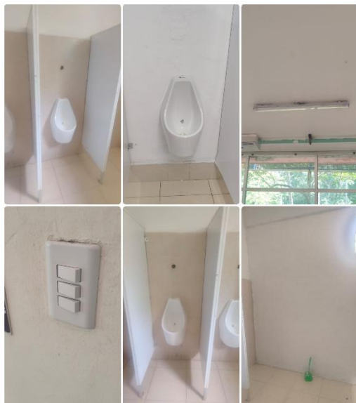
Imagen 21. Edificio Académico: cancelación de toma de agua y adecuación de tuberías para reemplazo de mingitorios tradicionales por secos, además de retirado de mosaico en mal estado y repellado de pared. También se reinstaló una lámpara descolgada.
