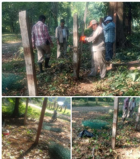
Imagen 31. Colocación de postes y malla ciclónica alrededor del vivero.
