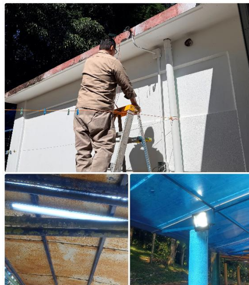
Imagen 30. Reparación de luminarias del andador que va hacia la Unidad Habitacional y alrededores de la cancha de usos múltiples.
