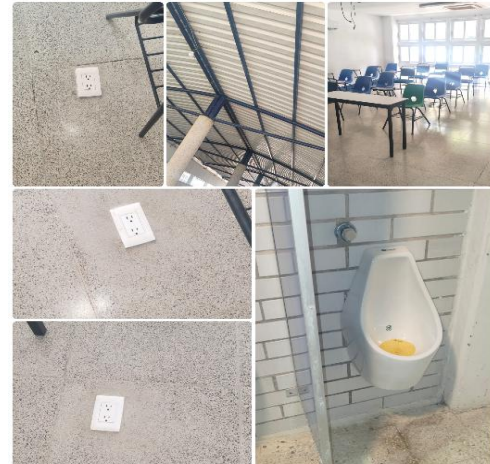
Imagen 19. Cancelación de toma de agua, adecuación de drenaje, instalación de 2 mingitorios seco, cambio de contactos por falla en el salón, cambio de pastilla termomagnética de los contactos del salón (no foto tablero estaba cerrado), y reparación del alumbrado del pasillo que va de multipropósito a horticultura.
