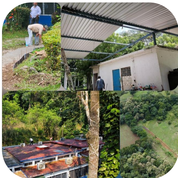
Imagen 2. Muestra de los diferentes trabajos de rehabilitación y mantenimiento.
