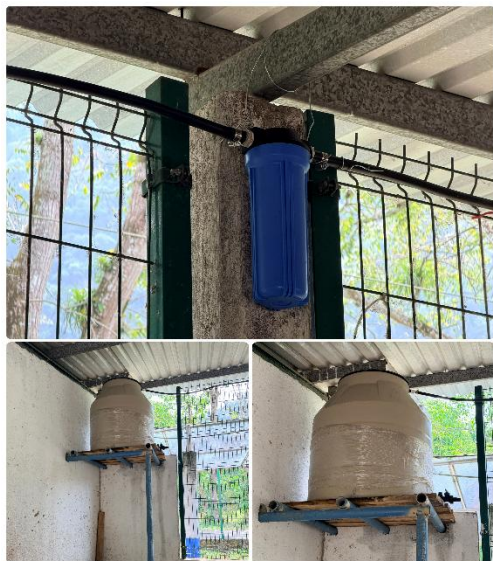
Imagen 27. Instalación de base para tinaco y tinaco, junto con su derivación para llenado y filtro, en el área de pequeñas especies del módulo de ganadería.
