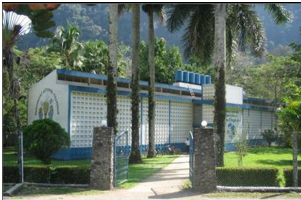
Figura 1. Edificio administrativo principal de la dirección del CRUSE.
